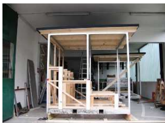
Grundaufbau der neuen Pavillons September 2014, städtischer Bauhof
