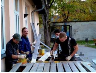
Streichen der Bretter und Montage der Holzbeplankung 4.11.-11.11.2014, vor Ort im Konviktgarten und am städtischen Bauhof
