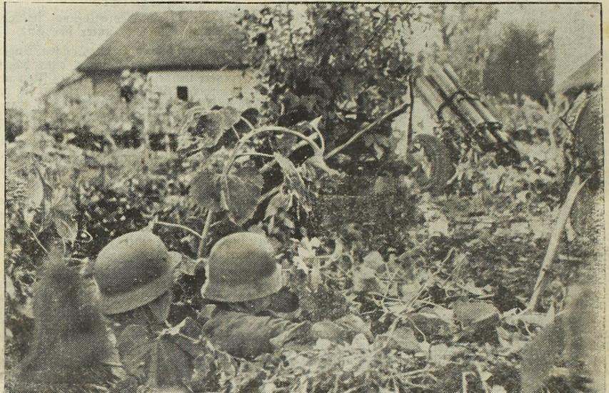
Nebelwerfer feuerbereit. Einer unserer Nebelwerfer fertig zum Auslösen der Raketen. Die Auslösung erfolgt elektrisch durch die Kanoniere, die etwa 15 Meter vom Werfer entfernt in Deckung liegen. (PK-Aufnahme: Kriegsberichtler Schneider, Sch., 3.)
